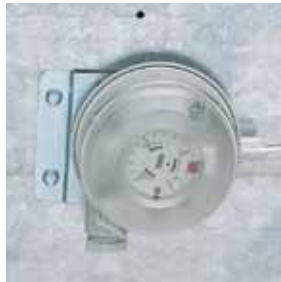
Pressostato montato a bordo.
