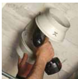
Fissaggio del supporto.
