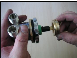
15 - Lösen der Messingmutter
