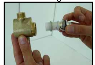
6 - Entfernen und Ersetzen der Patrone
