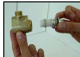
6 - rimuovere e sostituire la cartuccia
