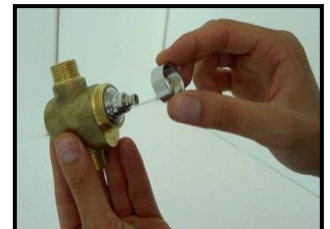
4 - Entfernen der inneren Ringmutter
