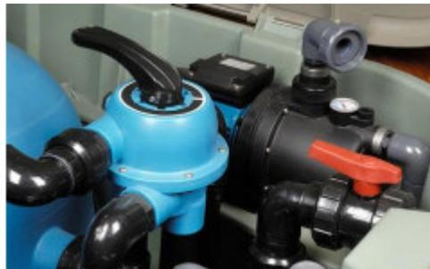
Pool Tiger ativa a uma taxa de fluxo mínima de 8 GPM. As bombas de velocidade variável devem ser ajustadas para garantir que a regulação da velocidade baixa é suficientemente elevada para ativar o dispositivo.
